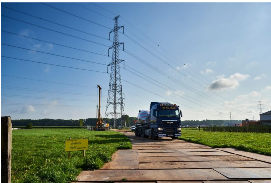
Figuur: Voorbeeld van rijplaten in een werfzone
