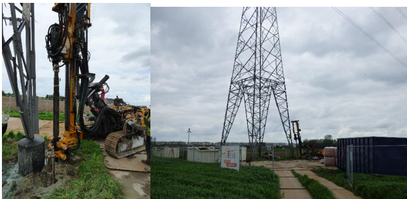
Figuur 19: Versterken van funderingen met micropalen
