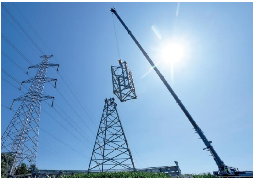
Figuur 8: Voorbeeld mastmontage
