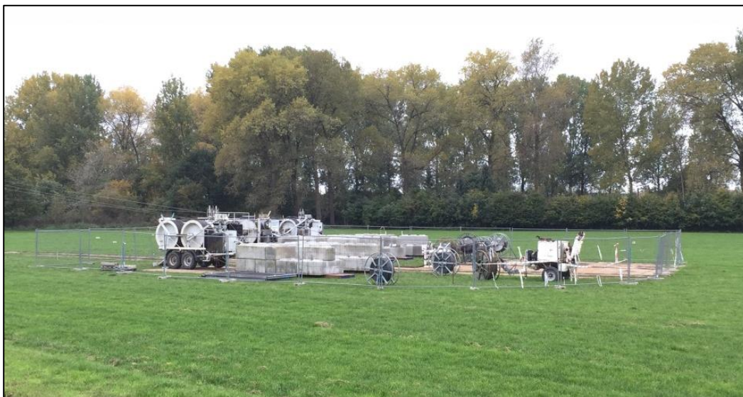
Figuur 10: Voorbeeldopstelling geleidertrek van een 4-bundel
