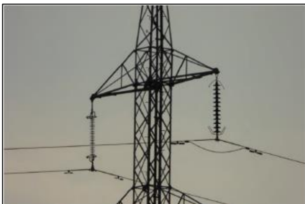
Figuur 12: Composiet isolator (links) en glazen isolator (rechts)
