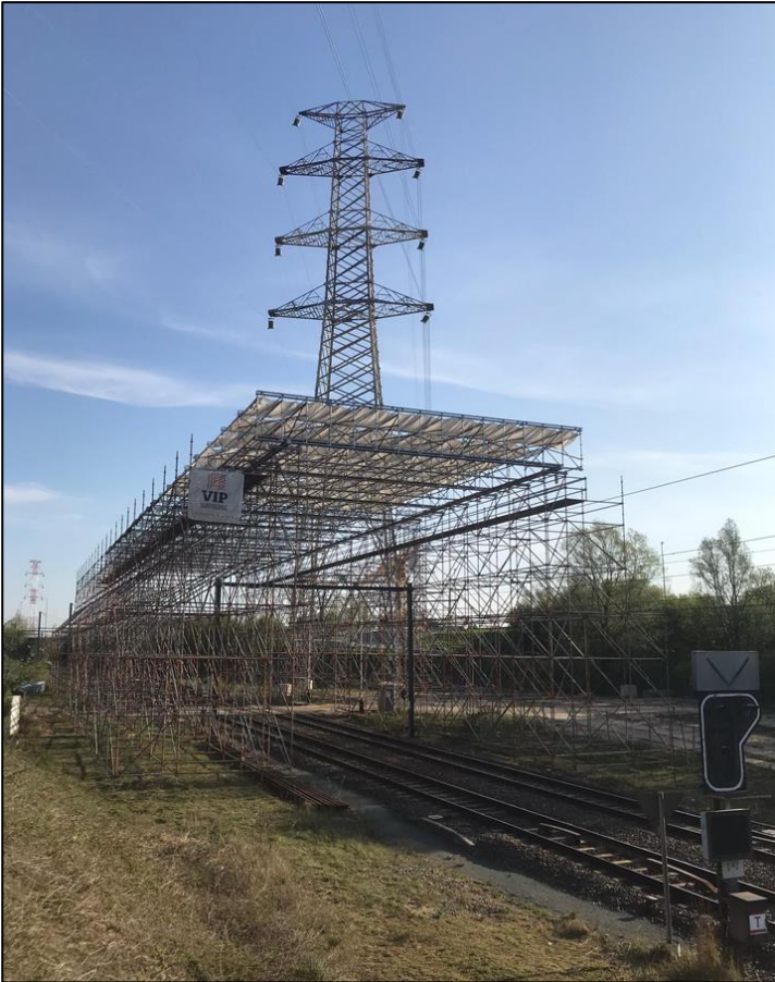
Figuur 16: Voorbeeld bescherming met stelling
