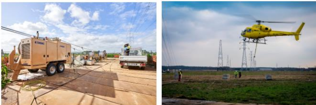
Figuur 9: Voorbeeld van mobiel remstation en helikopter met trekkoord
