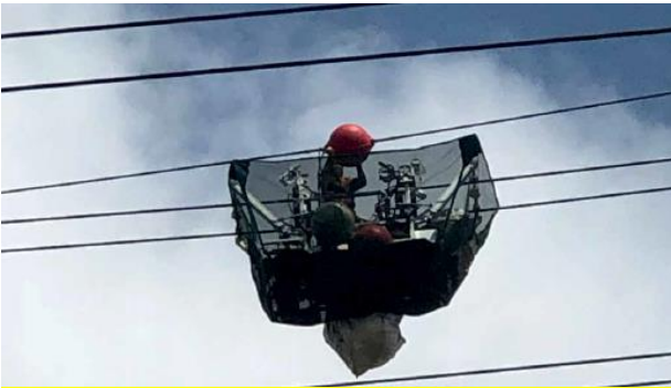
Figuur 25: Plaatsing van bepakeningsbollen
