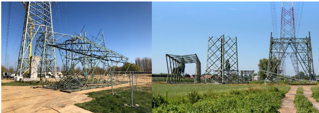
Figuur 7: Geassembleerde mastdelen in de werfzone
