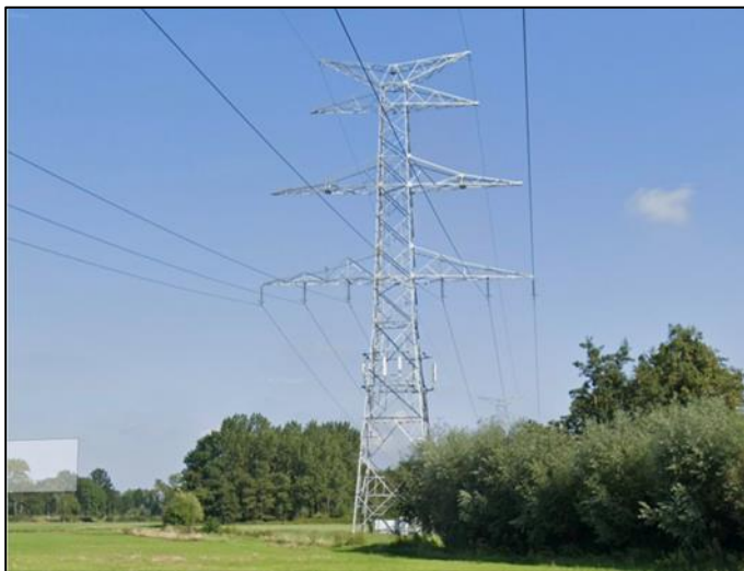
Figuur 23: Foto van de bestaande mastenrij met plaats voor bijkomende 380kV geleiders
