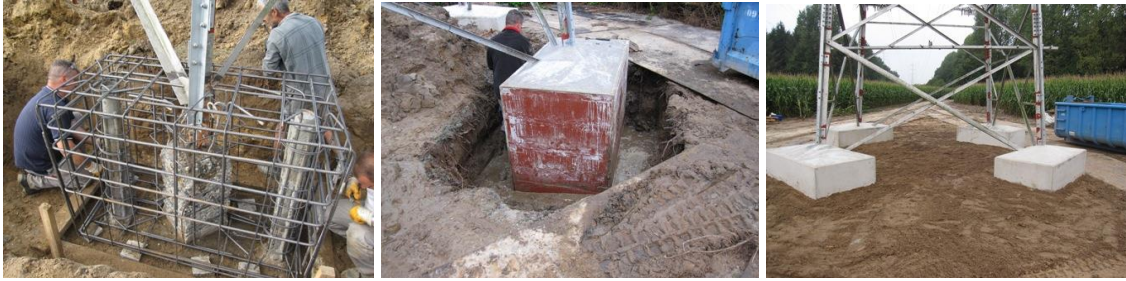
Figuur 20: Uitzicht van een versterkte fundering
