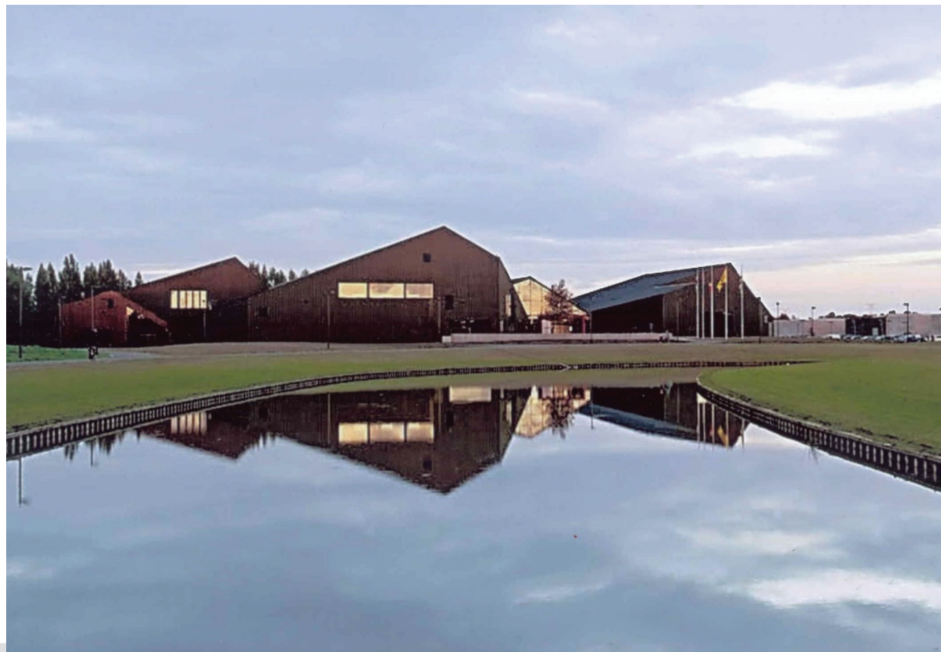
Eindverrekening van de bouw van het Vrijtijdscentrum Jabbeke – 8.725.765 euro (excl. BTW)
